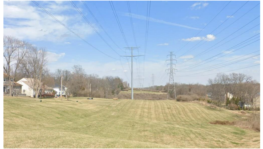
(Ameren Utility Corridor)
